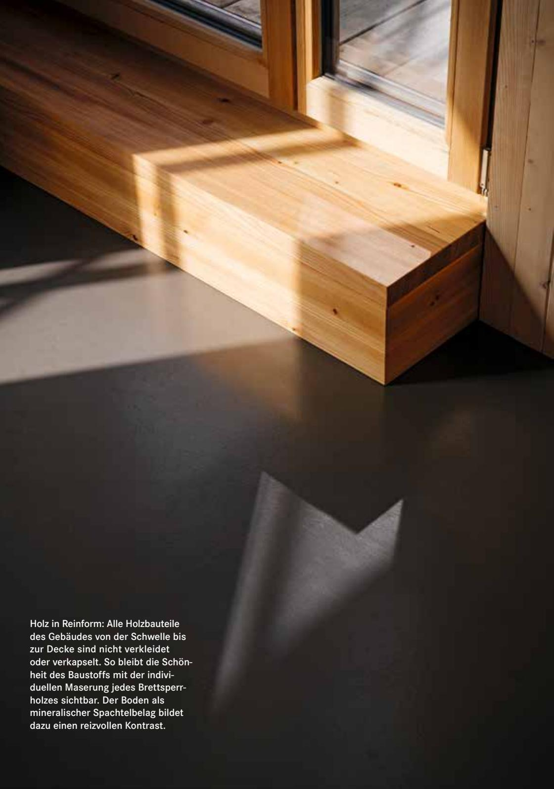
Holz in Reinform: Alle Holzbauteile des Gebäudes von der Schwelle bis zur Decke sind nicht verkleidet oder verkapselt. So bleibt die Schönheit des Baustoffs mit der individuellen Maserung jedes Brettsperrholzes sichtbar. Der Boden als mineralischer Spachtelbelag bildet dazu einen reizvollen Kontrast.
