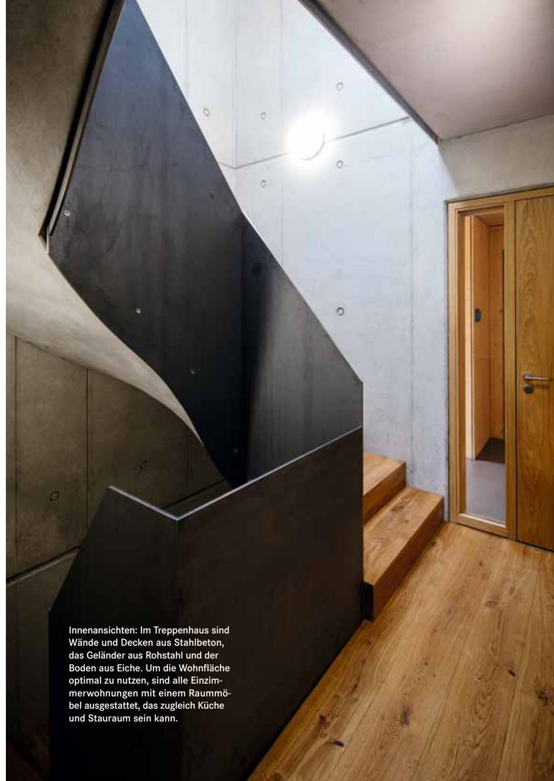
Innenansichten: Im Treppenhaus sind Wände und Decken aus Stahlbeton, das Geländer aus Rohstahl und der Boden aus Eiche. Um die Wohnfläche optimal zu nutzen, sind alle Einzimmerwohnungen mit einem Raummöbel ausgestattet, das zugleich Küche und Stauraum sein kann.
