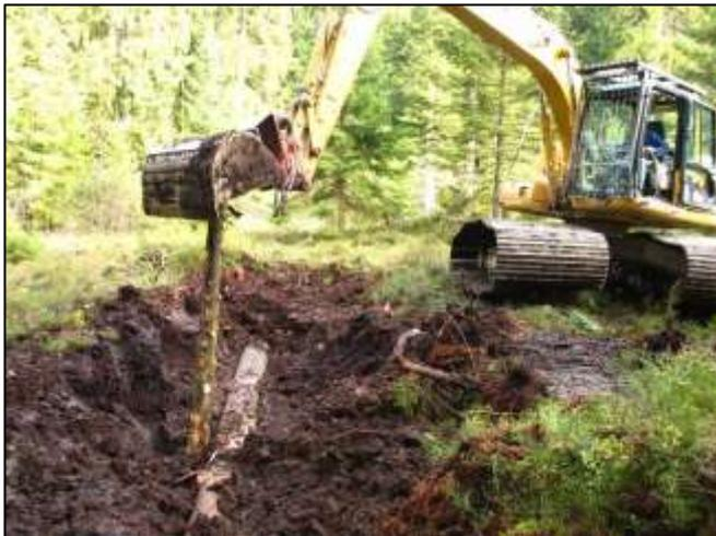
Abbildung 23 : Entstehung eines Torfwehrs im Kugelstattmoos - Einbau von Fichtenstammhölzern
