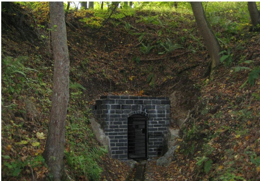
Abbildung 30: Stollenmundloch Rebeccastollen (F. Maier)
