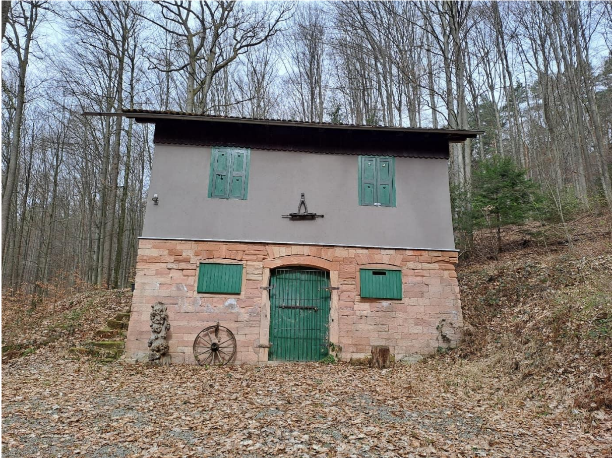
Abbildung 42: Fledermausfreundliche Forsthütte mit Einflugloch in den Kellerbereich. Der Keller wird regelmäßig als Winterquartier von Fledermäusen genutzt, Revier Hain.
