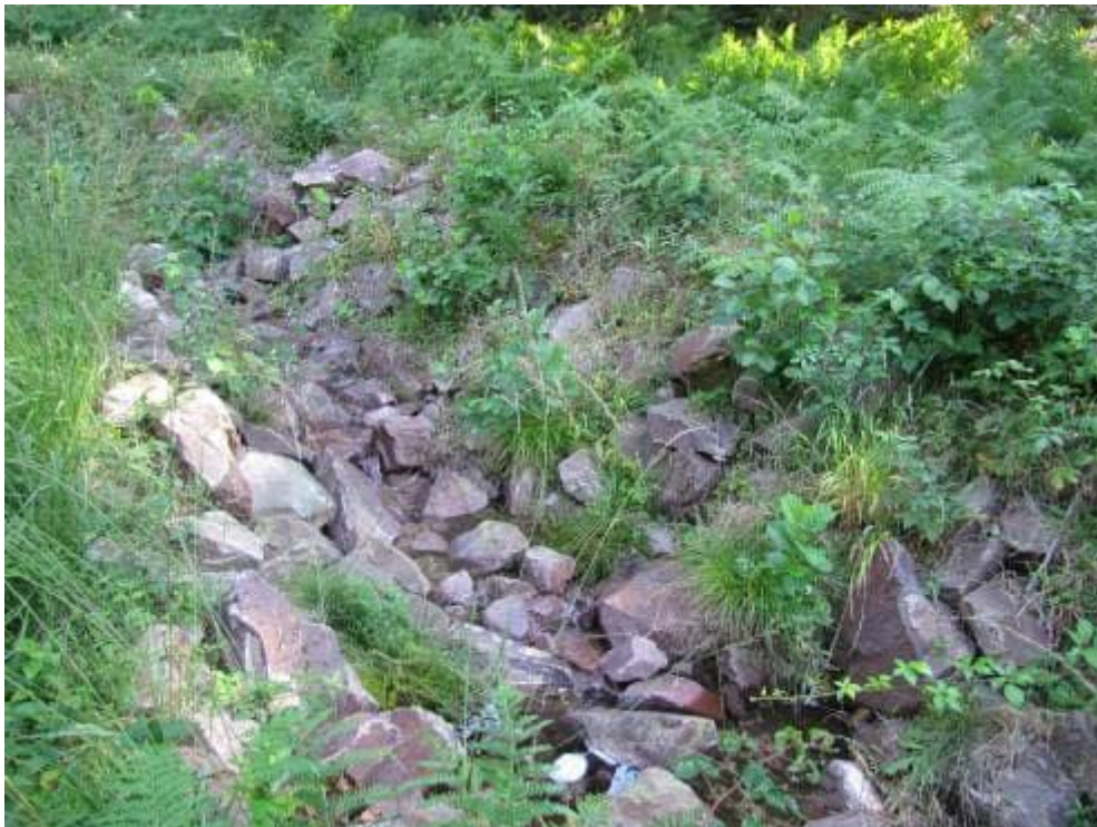
Abbildung 36: Künstlich angelegtes Umgehungsgerinne am Reifgrundsee
