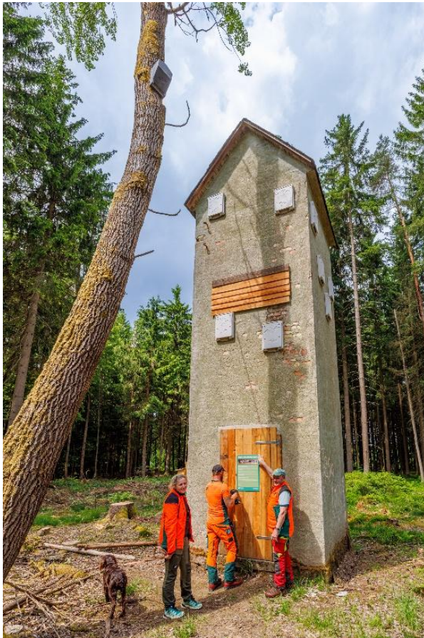
Abbildung 39: Fledermaus-Haus im Revier Nagel – eine ehemalige Trafo-Station
