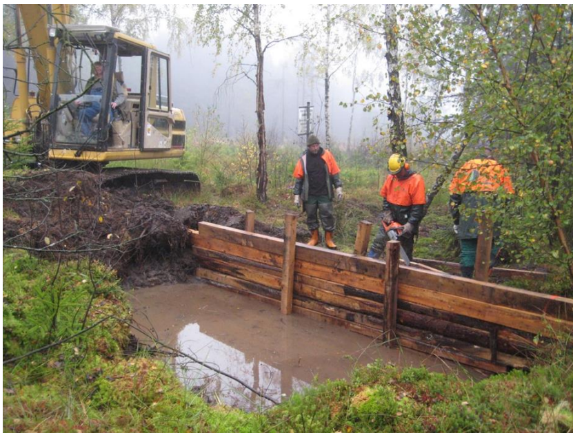
Abbildung 23: Einbau von Spundwänden aus Lärchenholz in Entwässerungsgräben des Strutmoors im Rev. Oberbach (Bild: A. Reichert)
