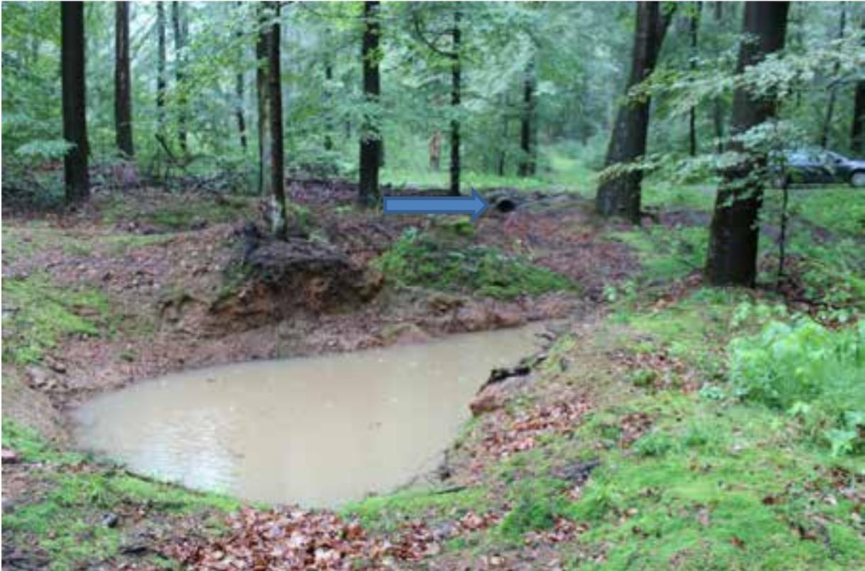
Abbildung 11: „Mini-Retentionsbecken“ nach Durchlass im Revier Langenprozelten (Bild: Reichert)
