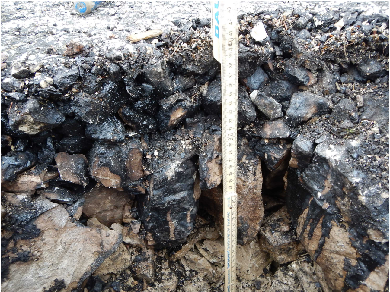
Foto 1: Leitprofil S-1 - Teerhaltige Deckschicht (Spritzdecke) und Straßenunterbau mit eingedrunenem Teer.
