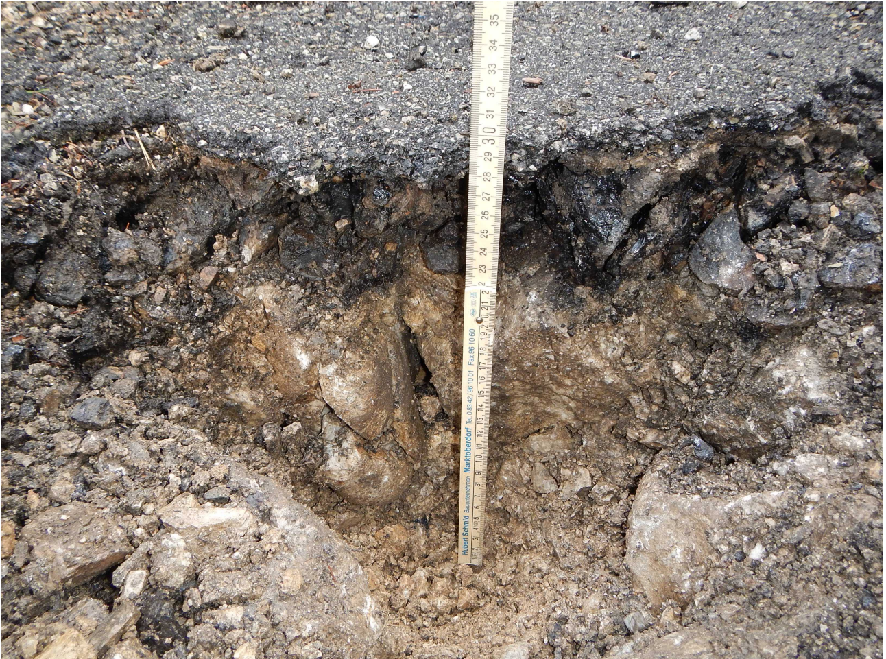
Foto 2: Leitprofil S-2 - Teerhaltige Deckschicht (Spritzdecke) und Straßenunterbau mit eingedrunenem Teer.
