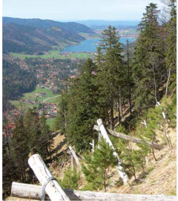
Der Bergwald über Schliersee schützt die Ortschaft vor Naturgefahren, insbesondere vor Lawinen. Im Rahmen der Schutzwaldsanierung errichtete Dreibeinböcke schützen junge Bäume beim Aufwachsen und verhindern gleichzeitig den Abgang von Lawinen.
