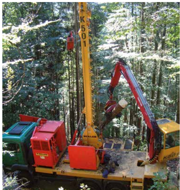
Ein Großteil der Holzernte im Gebirge findet in Hanglagen statt, wo keine Erschließung mit Rückwegen bzw. -gassen besteht oder möglich ist. Für eine bodenschonende Bringung werden unterschiedliche Seilverfahren eingesetzt, wie z.B. der Gebirgsharvester.
