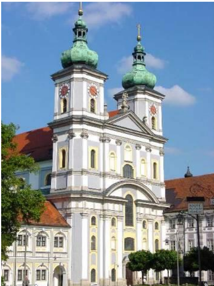
Abbildung 4: Kloster Waldsassen (Bild: ARCHIV FORSTBETRIEB WALDSASSEN)
