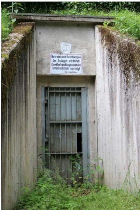
Abbildung 50: Möglichkeit der Schaffung eines Winterquartiers für Fledermäuse in einem ehemaligen Munitionsbunker (Bild: Reichert)
