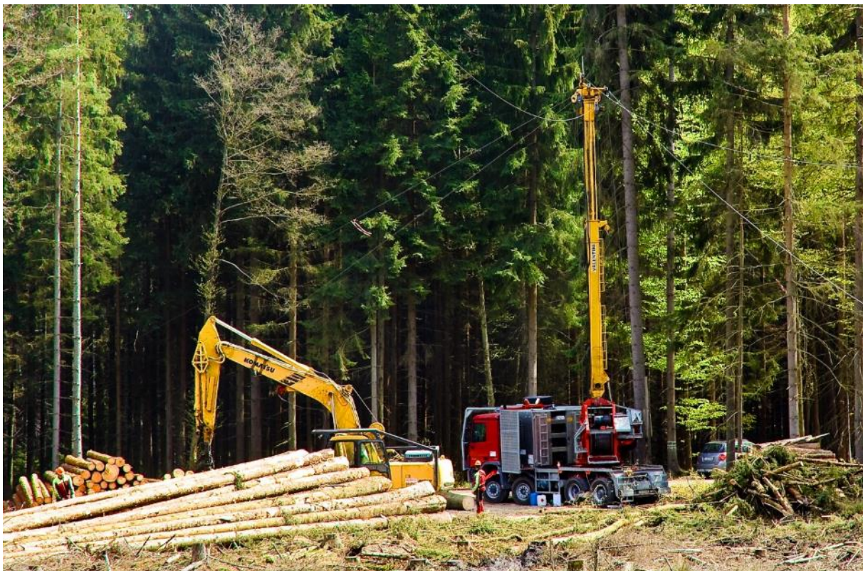
Abbildung 19: Bodenschonende Seilbringung bei einer Gewässerfreistellung im Revier Vordorf (Bild: Hertel)
