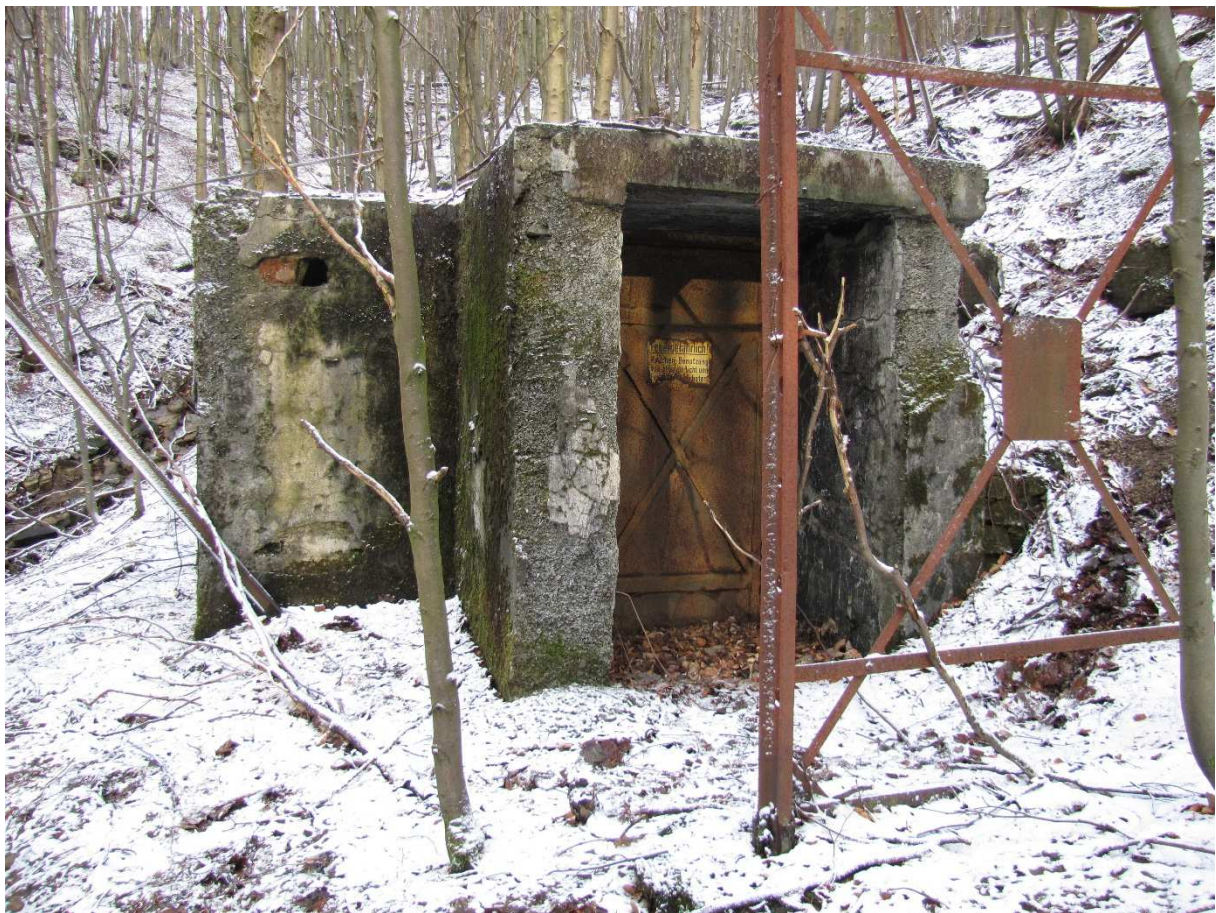
Abbildung 20: Alter Sprengmittelbunker eines ehem. Steinbruchbetriebs am Gebirgsstein (Autor: Reichert)
