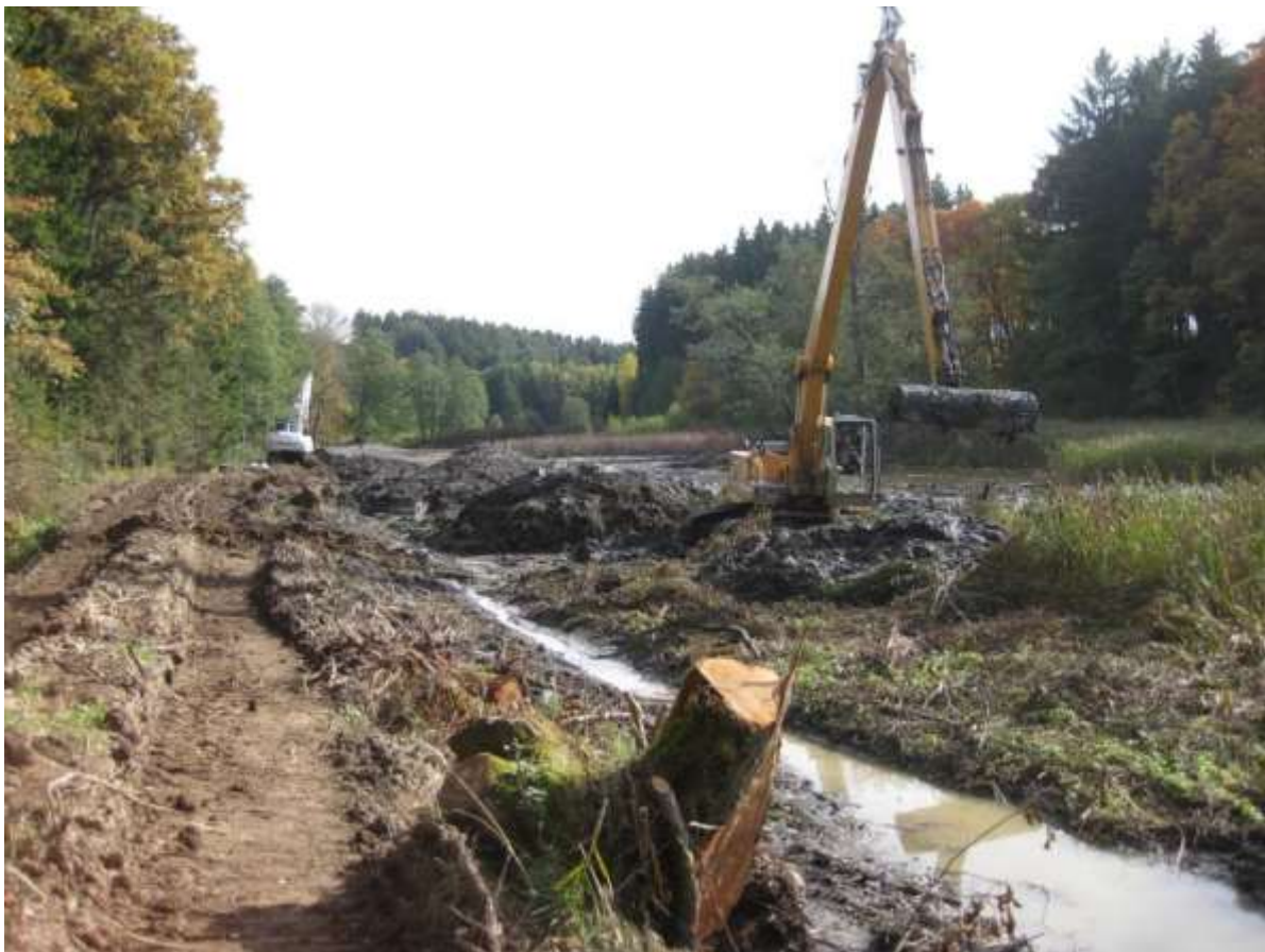
Abb. 26: Dammsanierung am Ochsenweiher
