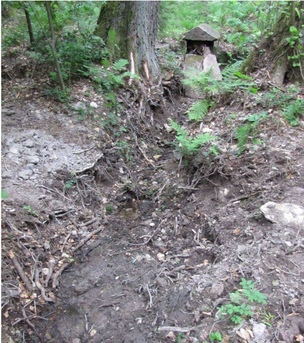
Abbildung 15: Renaturierungsmaßnahme am Naturdenkmal Kobertsquelle; der Beton in Quelltopf und Wasserablauf wurde entfernt und durch Bruchsteine und Erdreich ersetzt
