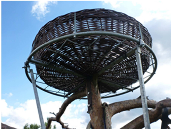
Abbildung 37) Kunsthorst-Unterkonstruktion
