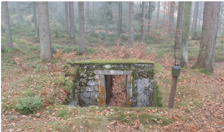
Abbildung 29: Ehemaliger Munitionsbunker im Revier Frauenberg, der sich evtl. für die Gestaltung als Fledermausbunker anbietet. Foto: Ebert
