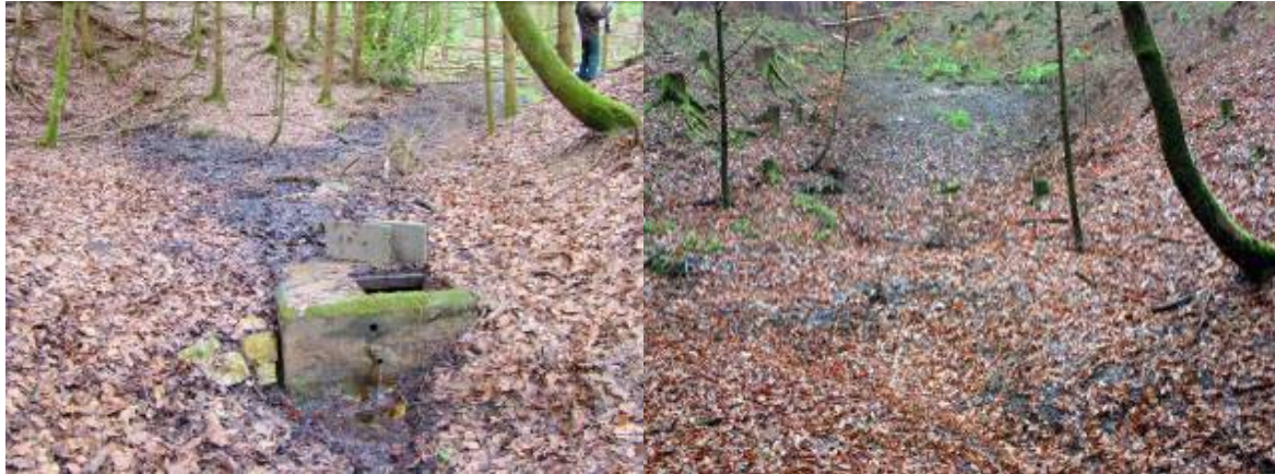
Abbildung 10: Fassungsrückbau in der Abt. „Brünnelschlag“; links: vor der Maßnahme; rechts: natürlicher Quellaustritt nach Rückbau (Bilder: Reichert)
