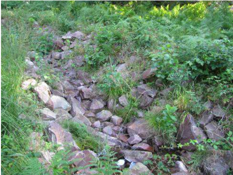
Abbildung 39: Künstlich angelegtes Umgehungsgerinne am Reifgrundsee
