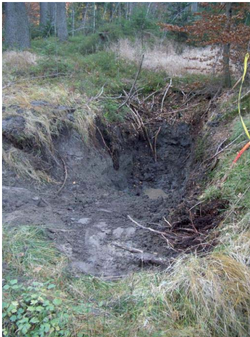
Abbildung 17 Sandfang als Maßnahme für den Erhalt der Flussperlmuschel im Wolfertsrieder Bach (Bildautor: UNB Landkreis Regen 2011)
