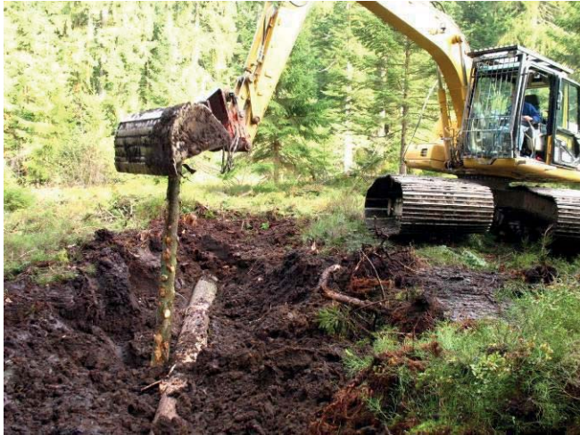
Abbildung 21 Entstehung eines Torfwehrs im Kugelstattmoos - Einbau von Fichtenstammhölzern (Bildautor: Siuda, Cornelia 2009)
