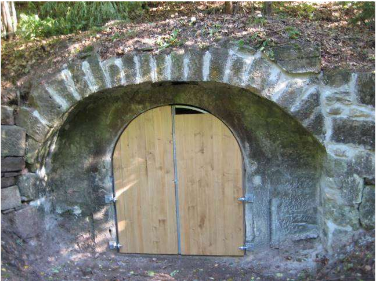
Abbildung 45: Sanierte Holztüre mit Einflugmöglichkeit für Fledermäuse an einem Felsenkeller bei Eichelsdorf in den Hassbergen (Bildautor: Rainer Fehn)
