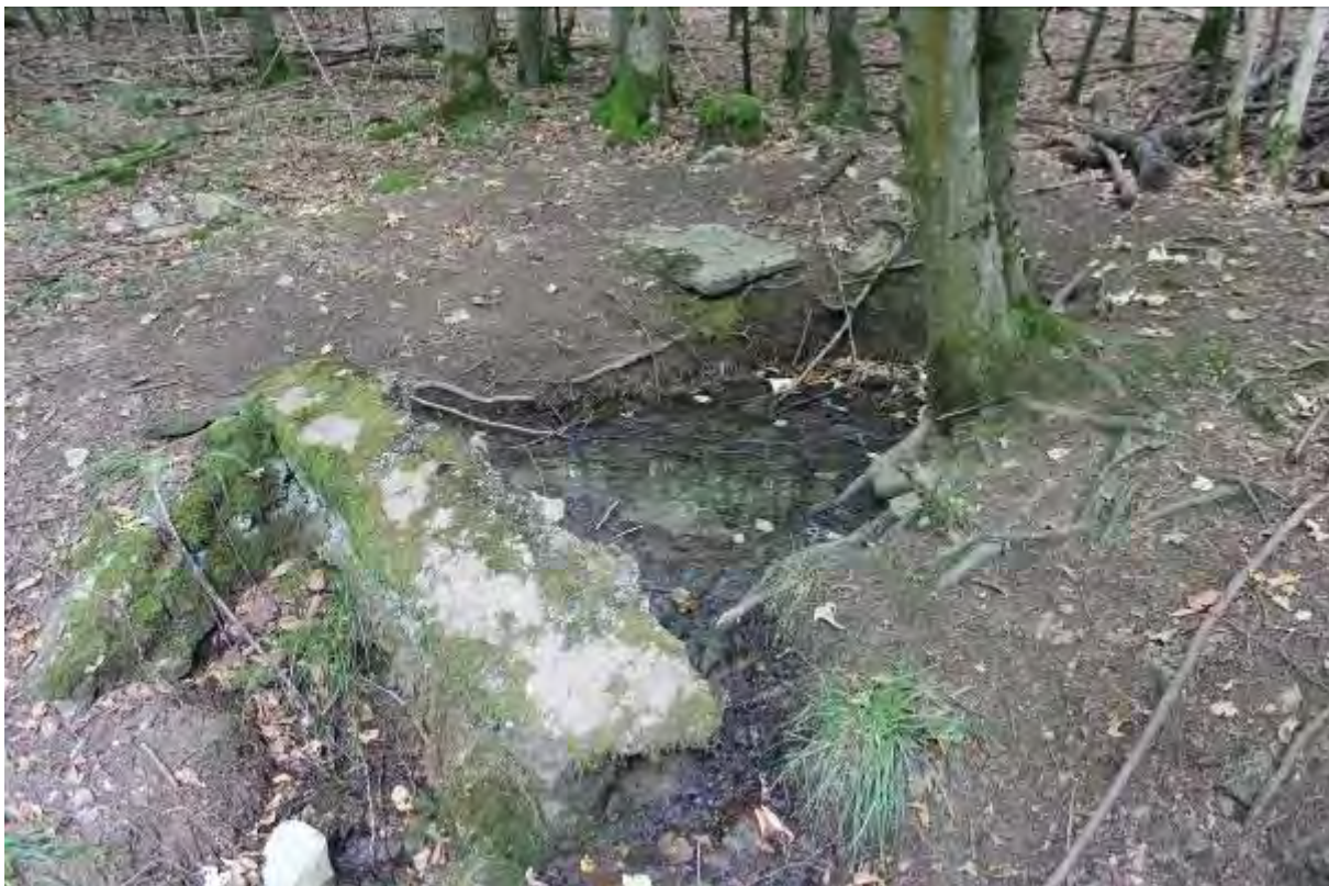
Abbildung 10: Durch Betonschwelle angestauter Quellaustritt im Distrikt 18 Abt. Schwarzland (Bild: A. Reichert)
