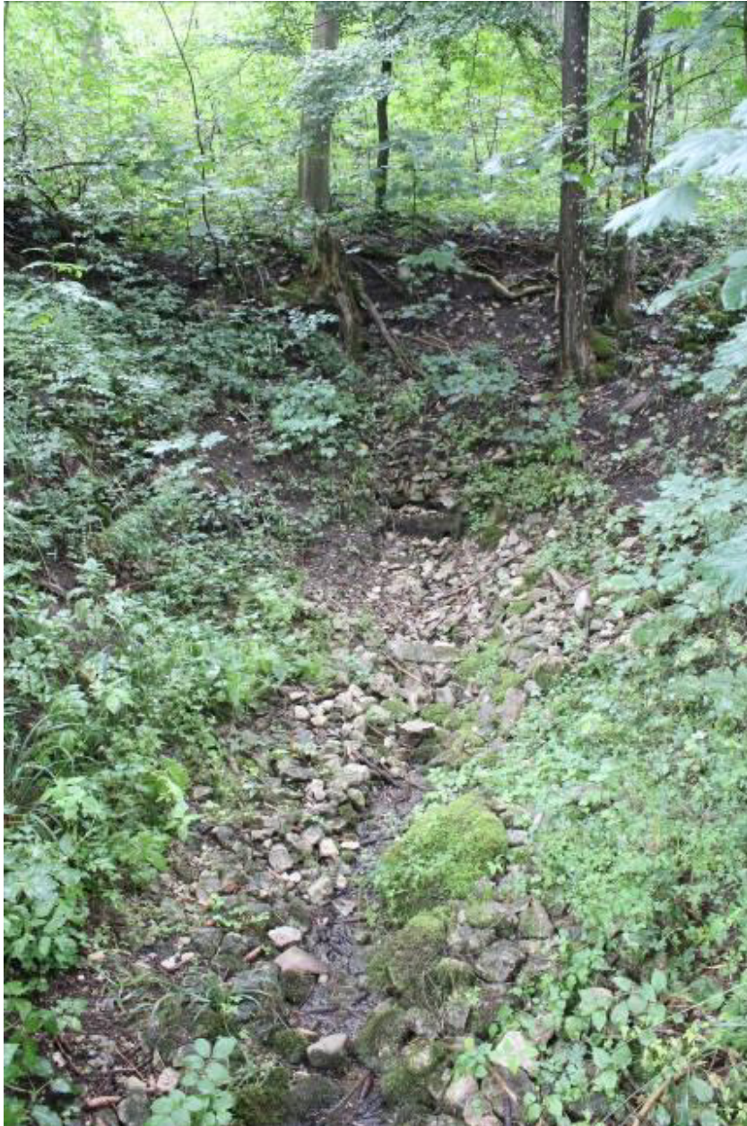
Abbildung 14: Rückgebaute Quelfassung und Schaffung eines natürlichen Quellaustritts mit Quellbach im Rev. Neumarkt (Bild: A. Reichert)
